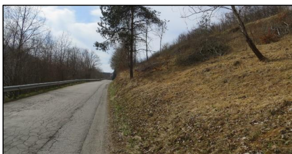
Slika 21: Slabo stanje voziščne konstrukcije na vzponu proti Spodnji Slivnici – pogled proti Sp. Slivnici.
