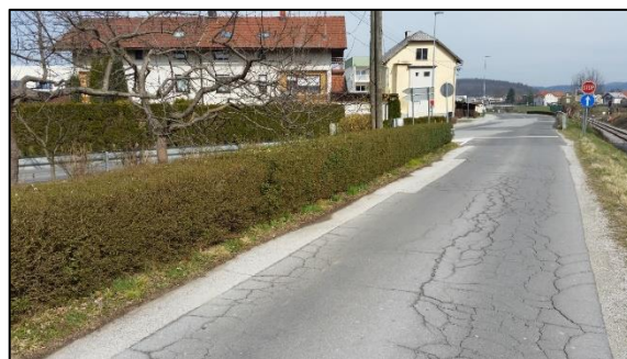
Slika 10: Slabo stanje voziščne konstrukcije na enosmerni cesti – pogled proti Taborski cesti.
