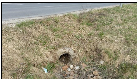
Slika 7: Obstoječi cevni prepust na Taborski cesti.
