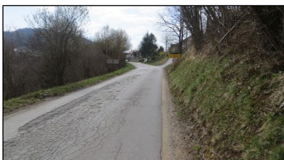
Slika 23: Slabo stanje voziščne konstrukcije pred vstopom v naselje Spodnja Slivnica – pogled proti Sp. Slivnici.
