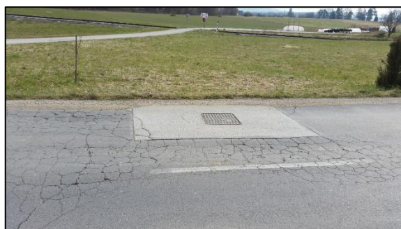
Slika 8: Slabo stanje voziščne konstrukcije na Taborski cesti.
